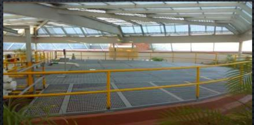
FOSAS DE AGUAS RESIDUALES, FABRICACIÓN E INSTALACIÓN DE EMPARRILLADO Y BARANDAL PARA SEGURIDAD DE PERSONAL.
