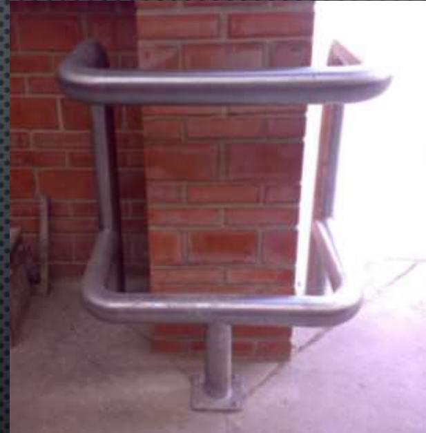
PROTECCIONES, EN MUROS PARA EVITAR GOLPEE EL MONTACARGAS, SON FABRICADAS CON TUBO 3" CEDULA 40 DE ACERO INOXIDABLE, ANCLADAS A PISO CON TAQUETE ARPÓN TAMBIÉN DE ACERO INOXIDABLE.
