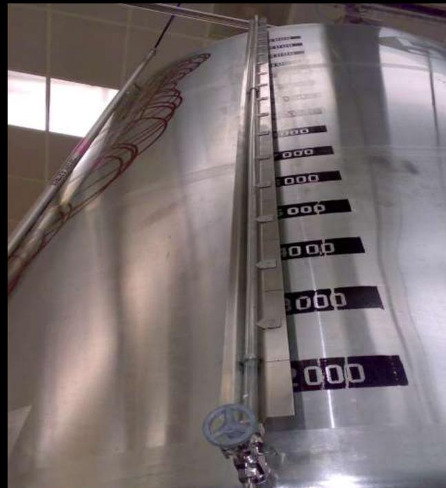
FABRICACIÓN E INSTALACIÓN DE PERFIL PARA APOYO Y PROTECCIÓN DE TUBO INDICADOR DE NIVEL, ASÍ COMO NÚMEROS GRABADOS PARA TANQUES.
