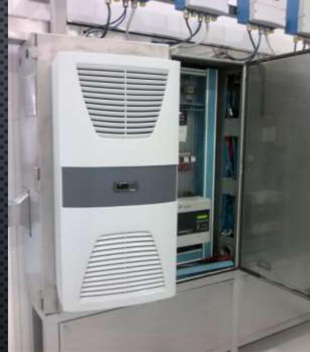
INSTALACIÓN DE AIRE ACONDICIONADO EN GABINETES DE CONTROL ELECTRÓNICO PARA ENFRIAMIENTO DE VARIADORES.
